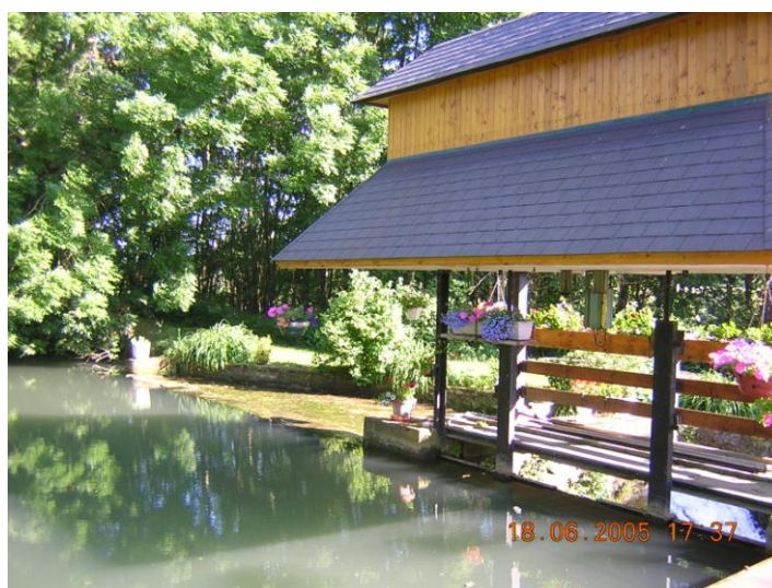
Figure 80 - Vannes de décharge et déversoir du moulin de Matron
