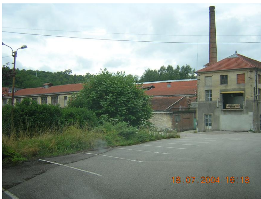
Figure 66 - Friche de la papeterie de Lisle en Rigault (2004)
