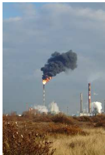
FIG. 5.2 – Rejet nocif ponctuel survenant au niveau des torchères d'usines pétrochimiques.
