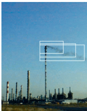
FIG. 5.5 – Disposition des zones de détection du système pour contrôler l’activité d’une usine pétrochimique. Les zones de détection sont disposées de manière à analyser l’évolution et la dispersion d’un rejet de fumées ponctuel survenant au niveau d’une torchère.
