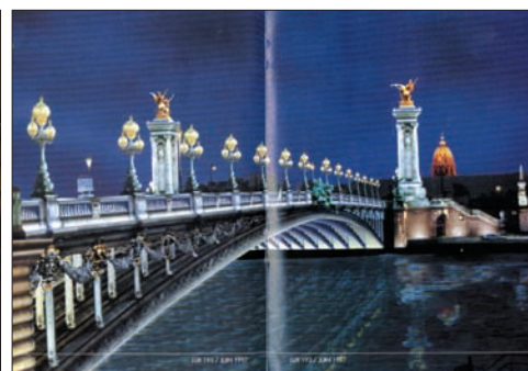
Archi. Lumière / pont Alexandre III
