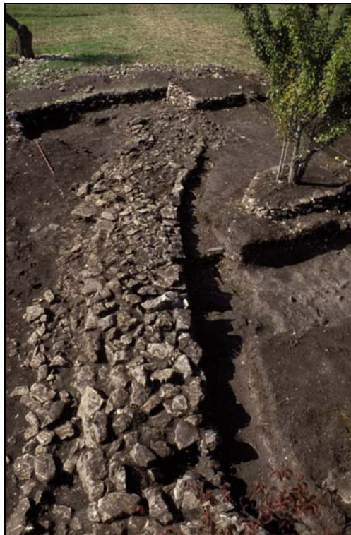
Fig. 117 : Mur en pierre sèche de La Brémonde construit selon la technique du double parement à remplissage interne (Cliché A. D'Anna)
