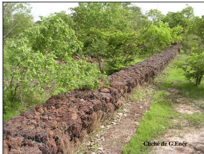
Photo n° 16 : Une des rares digues aménagées à Passakongo malgré le manque de moellons (Mouhoun, juin 2006)
