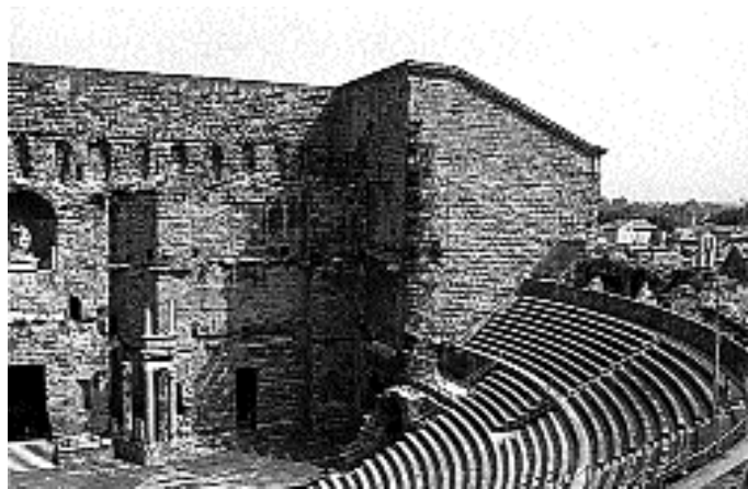
Fig. 479. Aménagement actuel de cinq rangs de gradins démontables contre le mur de la première praeinctio du théâtre d'Orange. (Phot. V. Chevrier.)
