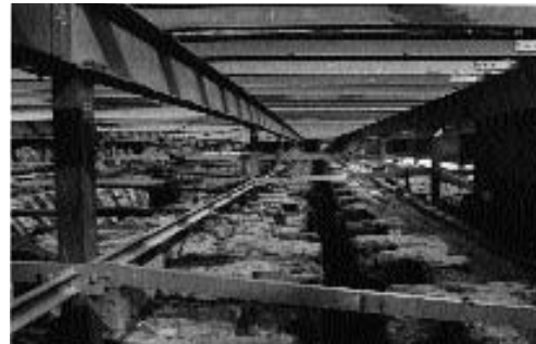
Fig. 423. Le plateau scénique du théâtre d'Orange recouvrant l' hyposcænium et la fosse du rideau. (Phot. V. Chevrier.)
