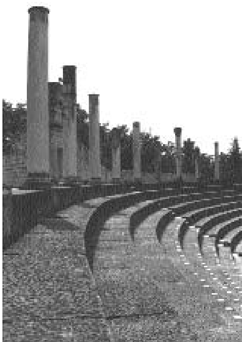
Fig. 316. Le portique supérieur de la cavea du théâtre de Vaison-la-Romaine restitué par J. Formigé vers 1930. (Phot. V. Chevrier, 1990.)
