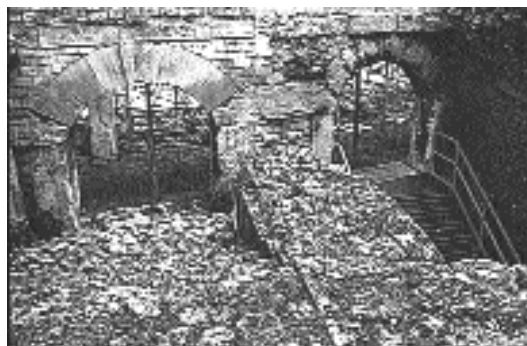
Fig. 503. L'un des escaliers métalliques dressés à l'amphithéâtre d'Arles suivant l'ancienne disposition d'accès entre la galerie du rez-de-chaussée et celle d'entresol. (Phot. V. Chevrier.)
