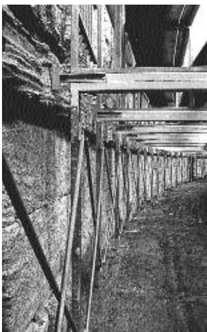
Fig. 491. L'ossature métallique de la tribune dressée au pied du podium de l'amphithéâtre d'Arles côté nord, fixée dans le sol de l'arène et prenant appui sur le mur. (Phot. V. Chevrier.)
