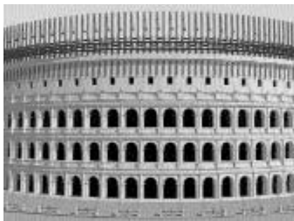
Fig. 453 a. Restitution du dispositif du velum au Colisée, 1996 : cippes de pierre au pied de l'édifice où auraient été fixé des treuils, et mâts de bois au niveau de l'attique à partir desquels auraient été tendu un réseau de cordages jusqu'à un anneau central situé au-dessus de l'arène. D'après l'équipe du « Pôle VILLE – Architecture, Urbanisme et image virtuelle » créé à l'Université de Caen en 1993. [ http://www.unicaen.fr/rome ]
