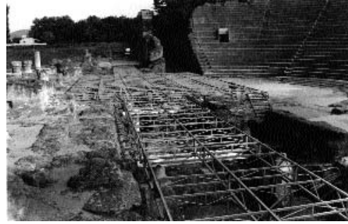
Fig. 422. L'armature de fer des plateaux de scène des théâtres d'Orange et de Vaison. (Phot. V. Chevrier.)
