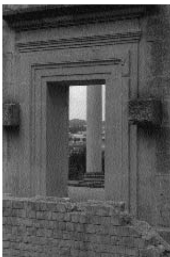
Fig. 323. La porte centrale à l'arrière du portique supérieur du théâtre de Vaison reconstituée par J. Formigé. (Phot. V. Chevrier.)
