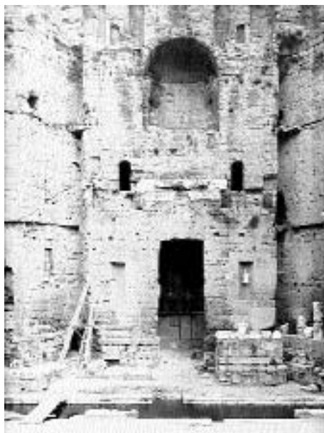
Fig. 524 b. La construction d'un stylobate en avant de la porte royale devant recevoir cinq fûts de colonnes. (Phot. C.N.M.H., mh171890.)
