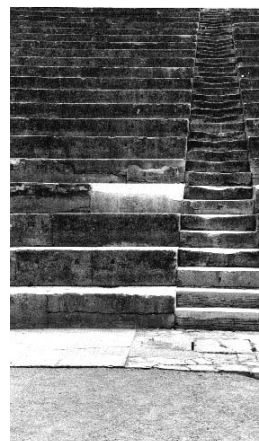
Fig. 331. L'égout romain recouvert par J. Formigé en pierres de Tavel posées sur une dalle de ciment. (Phot. V. Chevrier.)
