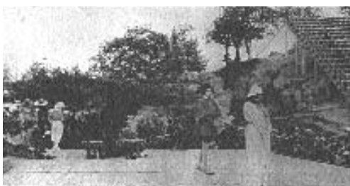
Fig. 480. Les premiers gradins de bois du théâtre de Vaison montés sur le flanc de la colline, 1922 et 1925. (Phot. fonds Ferme des Arts, Vaison.)
