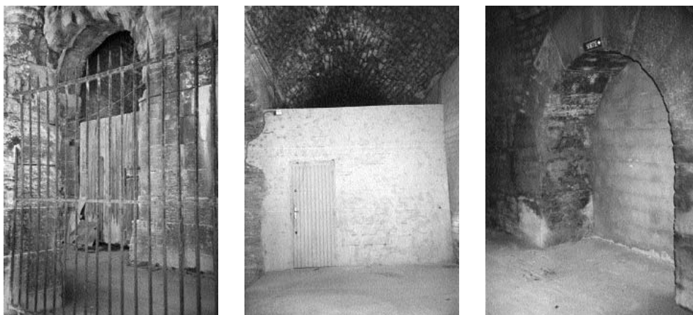
Fig. 406. Quelques travées de l'amphithéâtre d'Arles fermées à l'aide de portails de bois ou de murs de béton munis d'une porte permettant l'accès à un local technique. (Phot. S. Delarue.)
