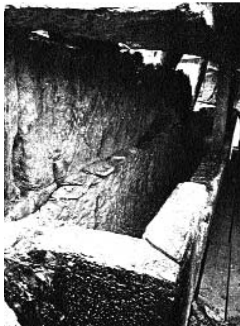
Fig. 333. Linteau de la galerie du second niveau à Nîmes évidé pour accueillir une poutre en ciment armé sur la hauteur de deux linteaux. (Phot. A. Chauvel, M.H.F., 1938.)
