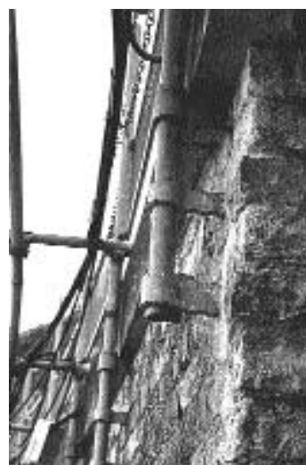
Fig. 514b. Scellements pratiqués dans le mur du podium d'origine de l'amphithéâtre d'Arles. (Phot. V. Chevrier.)
