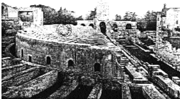
Fig. 292. « Arles. Vue extérieure du Théâtre Antique ». Rétablissement du mur de la galerie intérieure, vers 1910, côté nord. (Carte postale, phot. ND, n° 56, Méd. d'Arles.)
