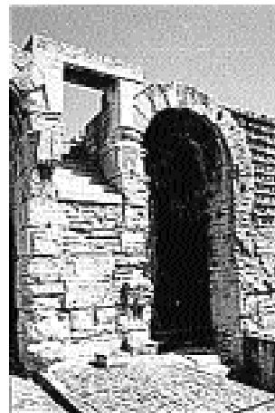
Fig. 346. L'escalier inscrit en 1905 par J.-C. Formigé de manière systématique une travée sur deux entre les arceaux du premier étage de l'amphithéâtre d'Arles. (Phot. V. Chevrier.)
