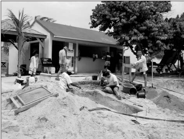
a. le sondage 17 en cours de fouilles
