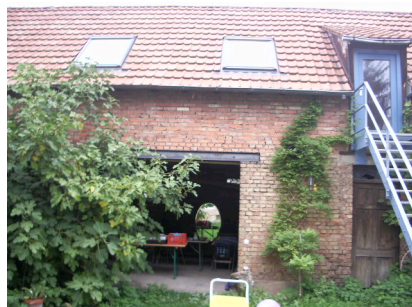
64. Grange, vers le Nord, octobre 2005
