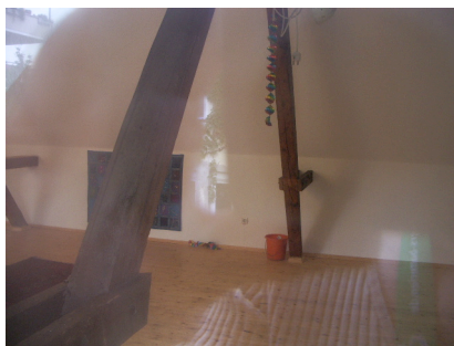
65. Grange, vers le Nord, octobre 2005
