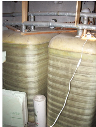
87. Cave, réserve de fioul, vers façade Ouest, octobre 2005
