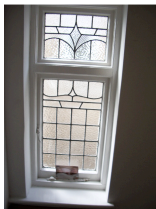
54. Escalier, vers façade Sud, septembre 2005
