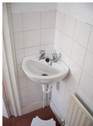
44. Cabinet de toilettes, Est, septembre 2005
