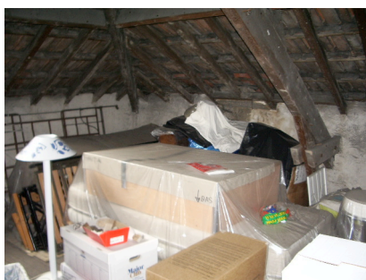
29. Grenier, vers angle Sud, juillet 2005
