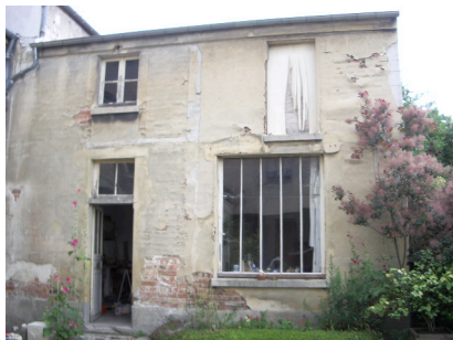
12. Atelier, façade Sud-Ouest, juillet 2005
