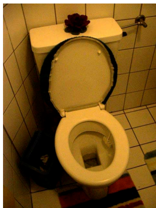
74. Cabinet de toilettes, vers façade Ouest, octobre 2005
