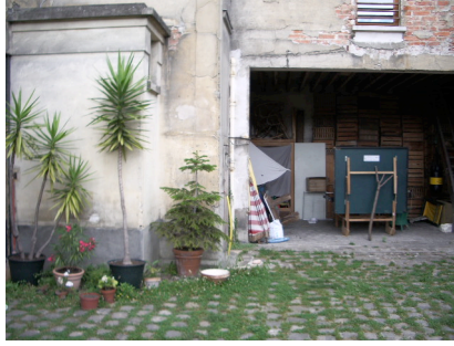
4. Cour, Sud-Est vers Nord-Ouest, juillet 2005
