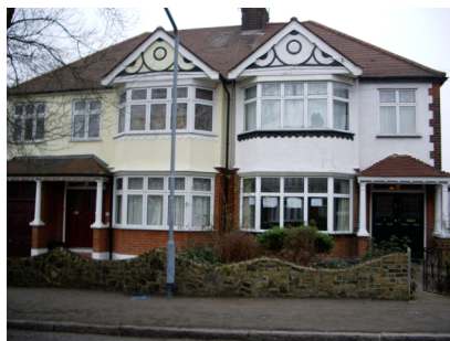
31. Façade de la maison, Nord-Ouest, février 2006
