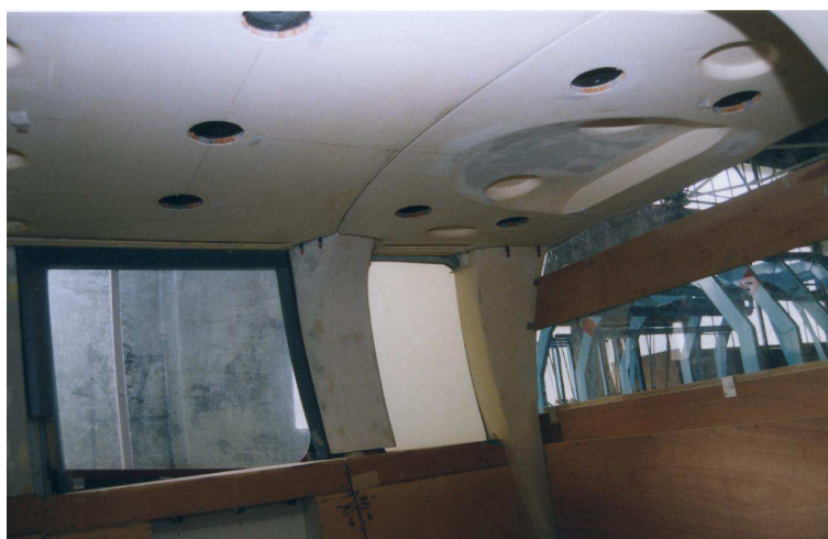
Fig. 1.16 : Vue des haut-parleurs de contrôle (Photo tirée du rapport du LMA).
