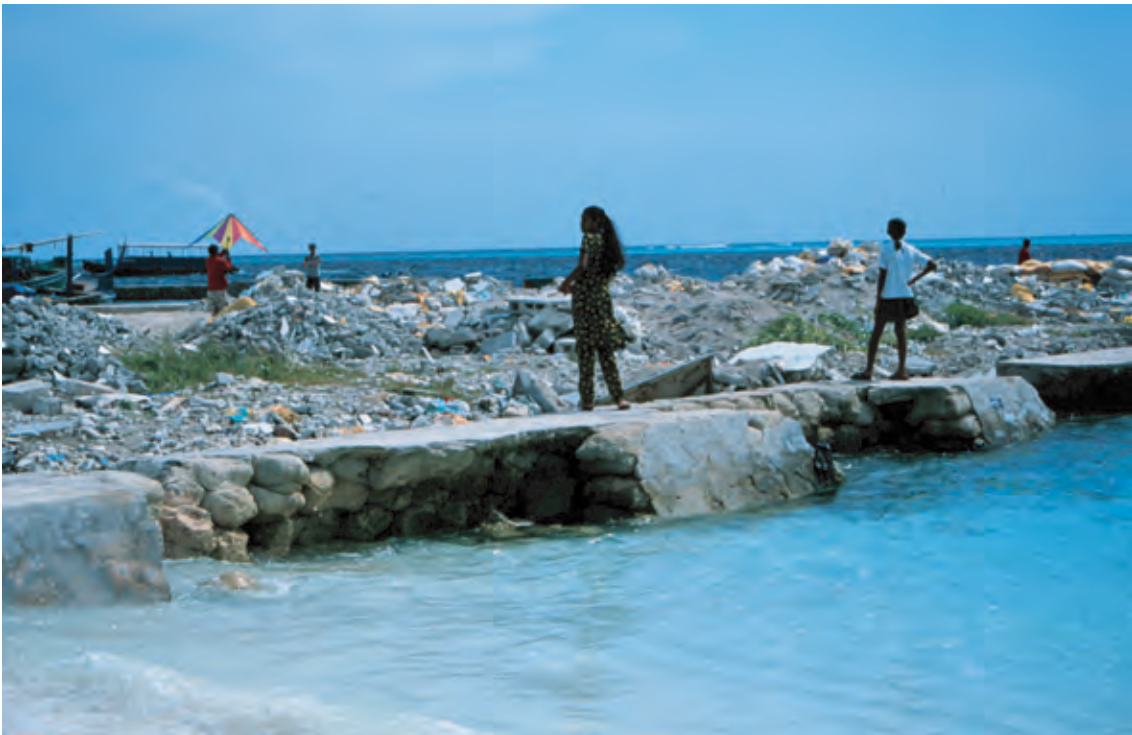
Île de Vilingili, quai nord-nord-ouest en 2001
