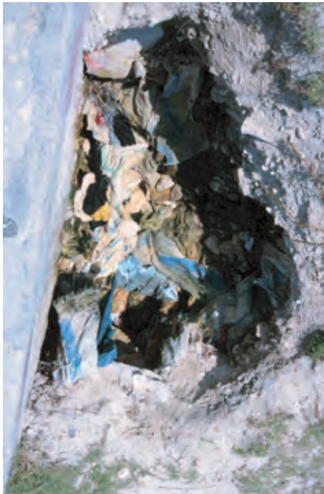
Tapis de déchets servant de soubassement aux anciens polders de Malé (Maldives) - côte nord-est
