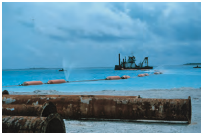
Pompage de sédiments lagunaires pour la construction de l'île artificielle d'Hulhumalé (Maldives)
