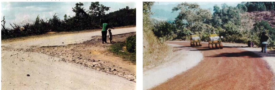
Photo 6 : Route Phongsaly – Boun Neua Avant / après réparation (photo PDDP)
