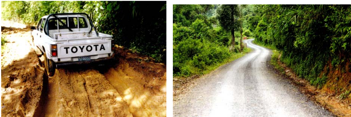
Photo 7 : Route Phongsaly – Hatsa Avant / après réparation (photo PDDP)
