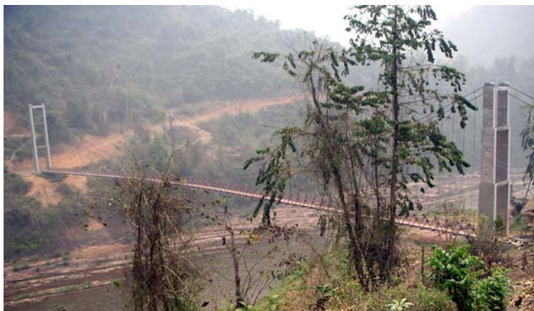
Photo 10 : Pont câblé sur la Nam Ou (Vangsay, 2003)
