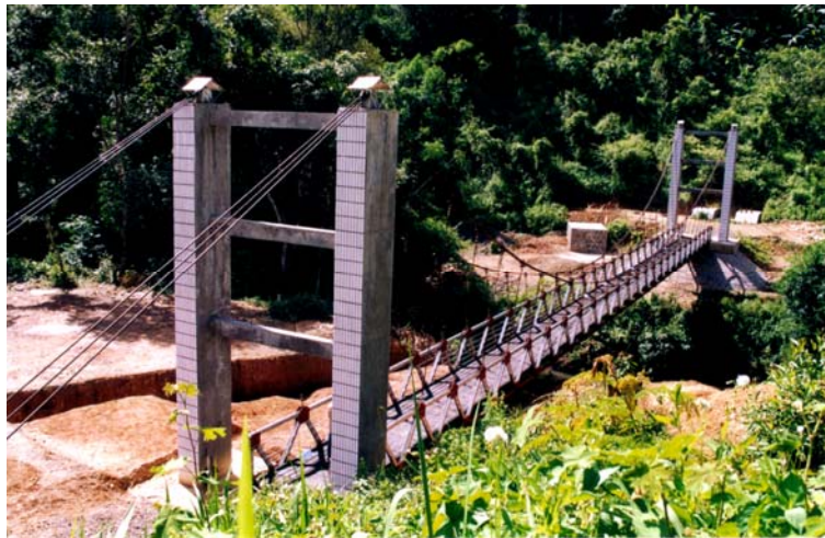
Photo 9 : Pont câblé sur la Nam Thè (Say, 2001)
