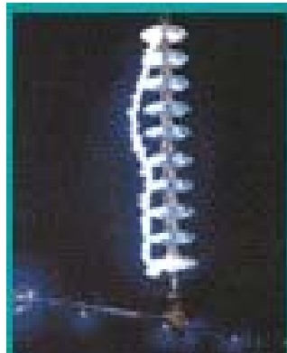
Figure 4: Chaîne d'isolateurs en situation de contournement électrique en laboratoire.
