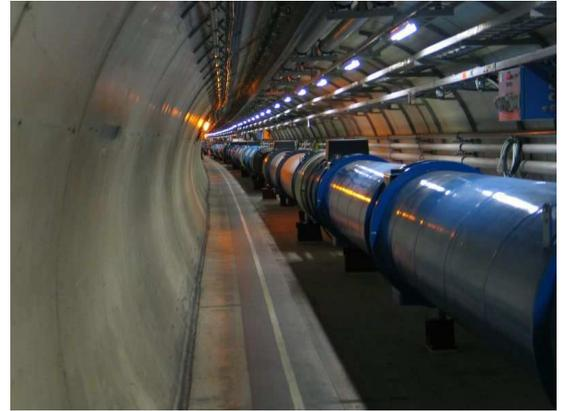
FIG. 2.3 – Dipôles installés dans le tunnel du LHC [30]
