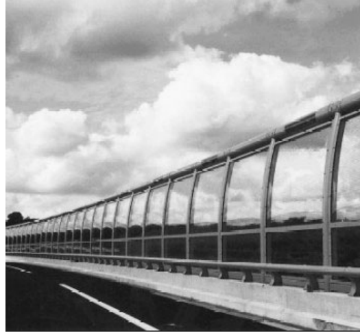
Figure 2.3 Ecran anti bruit partiellement incliné transparent en PLEXIGLAS® installé sur l'A14 en Normandie, Concepteur : IB TRADING
