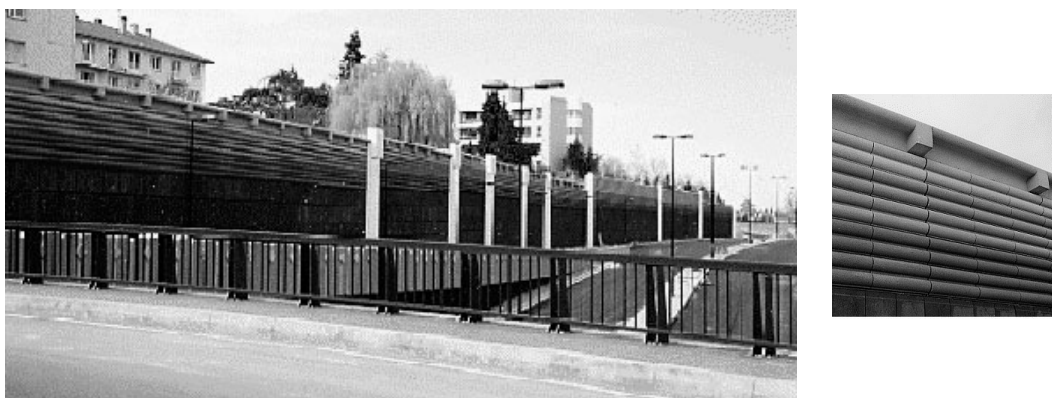
Figure 2.6 Écran avec couronnement en Té installé à Roanne
