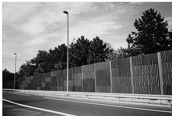
Figure 2.2 Ecran anti bruit droit en béton de bois absorbant, Fabriquant : CAPREMIB
