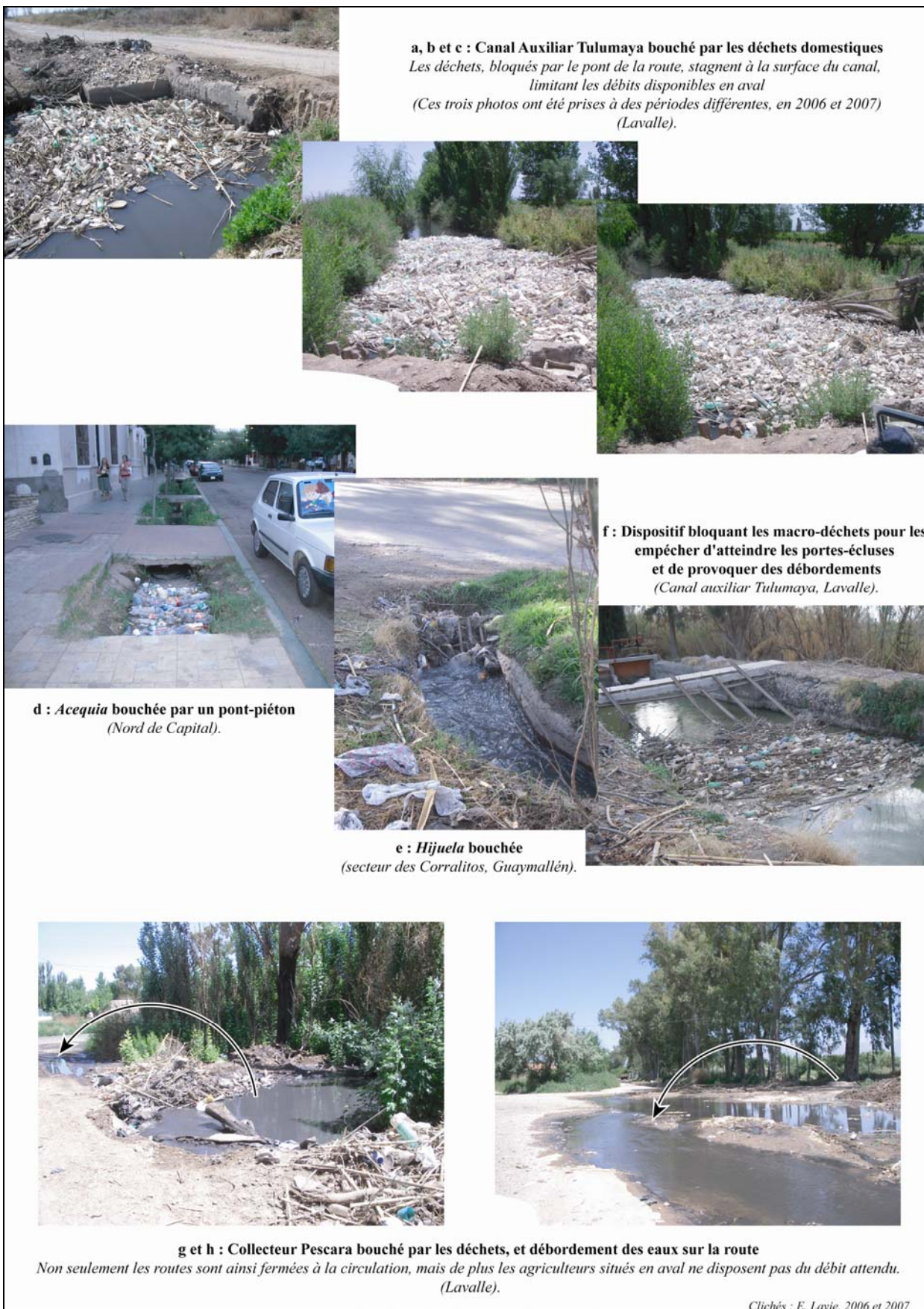
Planche photos 8 : Infrastructures bouchées par des macro-déchets, limitant ainsi les débits et donc l’approvisionnement en eau des irrigants
