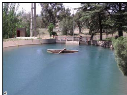
a : Barrage de Cipolletti (RI) Ces eaux de couleur bleue partent en rive droite (CIV) par l'entonnoir central.
