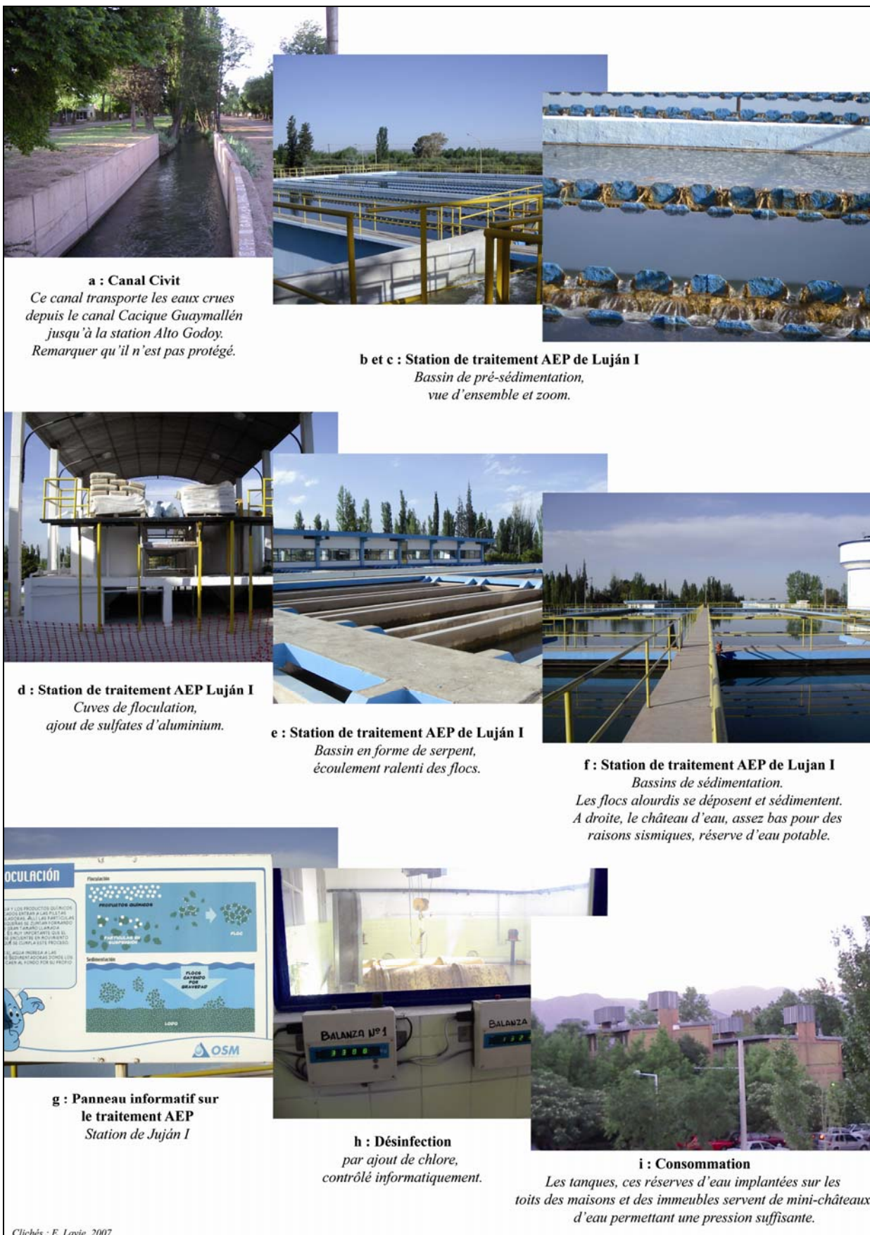
Planche photos 2 : Traitement et adduction d'eau potable
