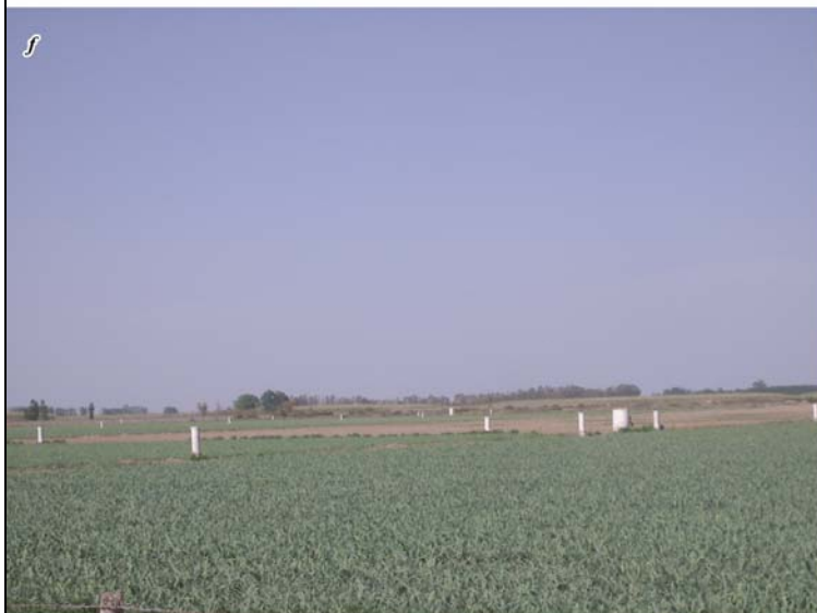
f : Bouches d'aération en secteur d'irrigation par eau souterraine
