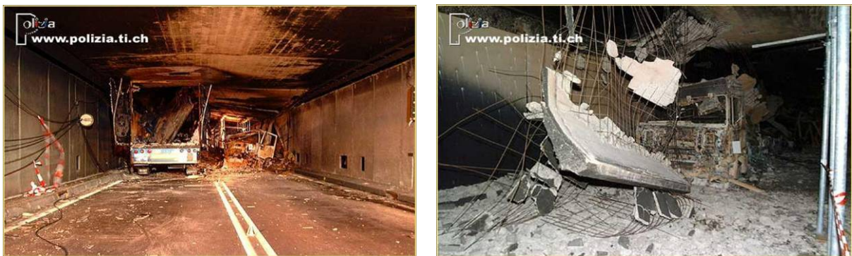
Figure 3 : photos du tunnel du Saint Gotthard suite à l'incendie de 2001. A droite, effondrement du faux-plafond en béton du tunnel provoqué par l'incendie.
