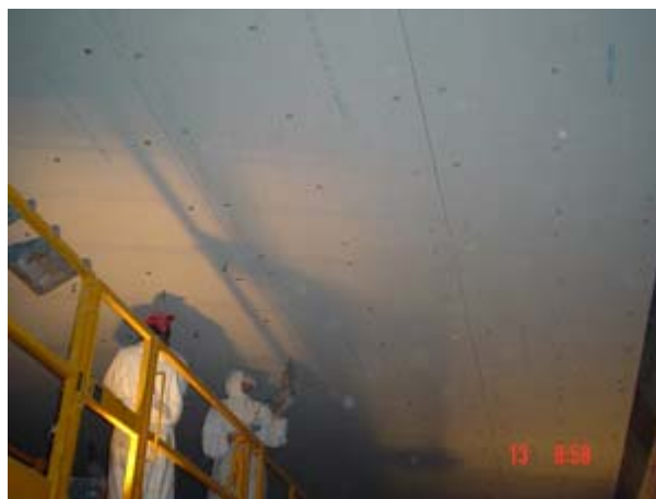
Figure 11 : installation d'une protection thermique rapportée sur la dalle d'un tunnel ( documentation Promat ).
