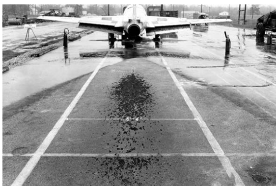
Figure 6 : à gauche, état d'une piste de décollage en béton à la suite de l'allumage du réacteur d'un avion de chasse. A droite, explosion d'éprouvettes cylindriques chauffées lentement dans un four électrique (Bohn M., Gianaria A. et al. 2008).
