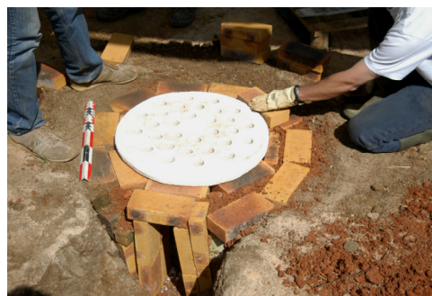
Figure 79 - Pose de la sole sur le cendrier.
