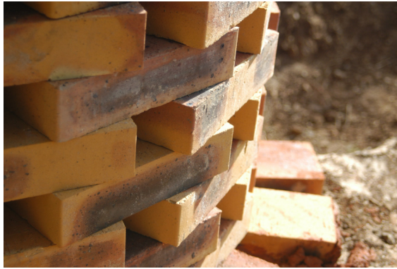
Figure 80 - Détail de la construction du foyer.
