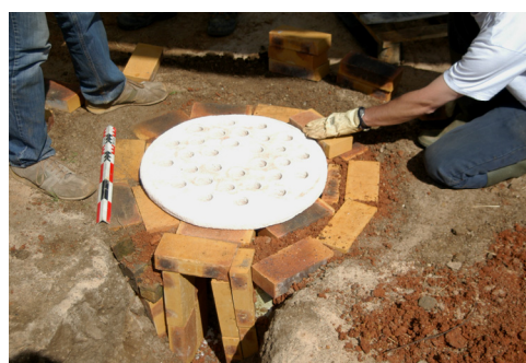
Figure 79 - Pose de la sole sur le cendrier.
