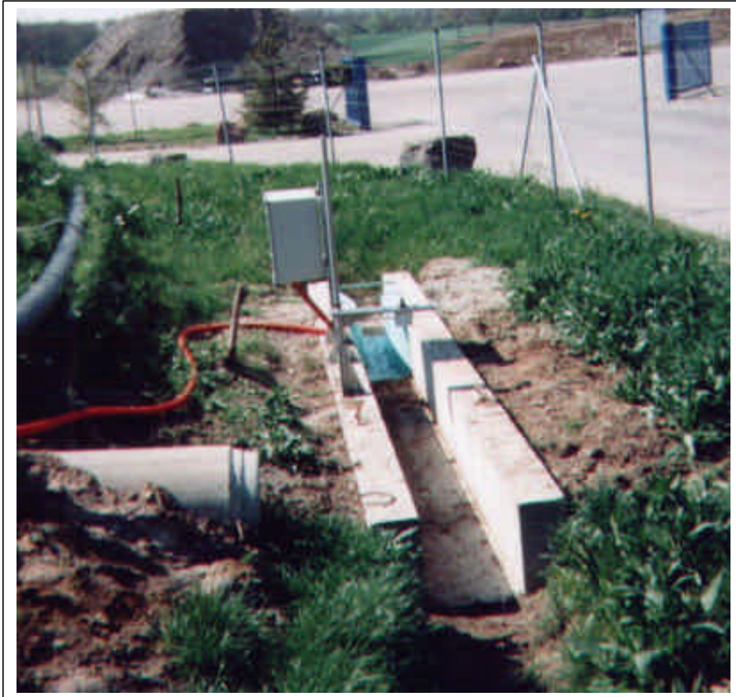
Figure B7 : Photo de l'instrumentation pour la mesure de ruissellement
