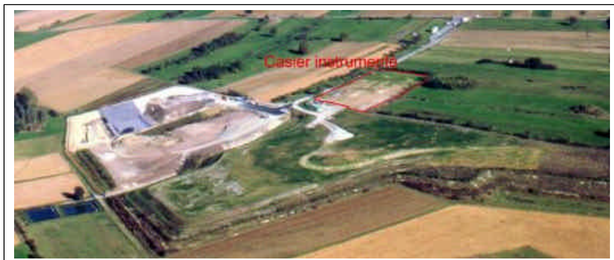
Figure B3 : Situation du casier instrumenté
