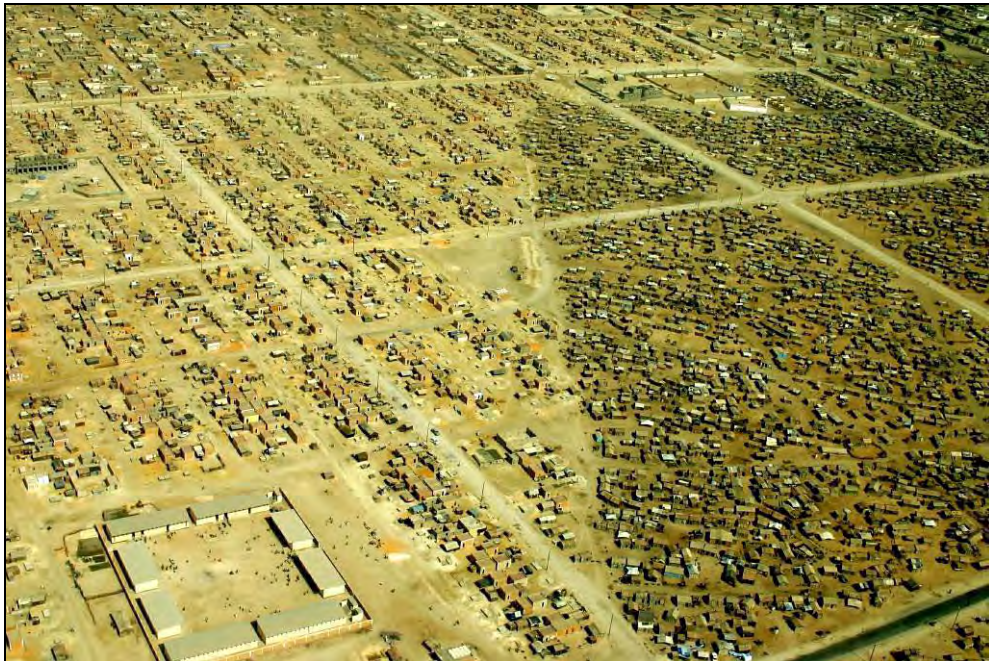
Photo 21 : La kebbe, vue aérienne
