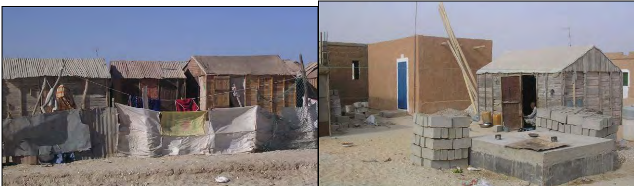
Photos 22 a et b : La kebbe d'El Mina : avant et après recasement
