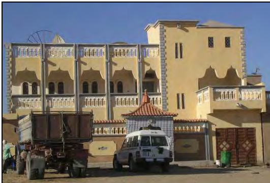
Photos 28 a et b : Les villas de Nouakchott (Tevragh-Zeina)
