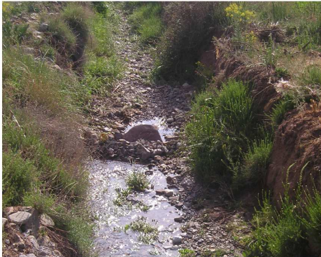
Ouggoug : prise d'eau du canal tamazoust sur l'assif à Akourbi (cliché : Fardau, mai 2002)
