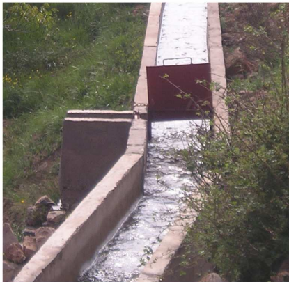
Ouvrage de transversement équipé de vannes sur le canal N'Oufilla de Rbat bétonné en 2001 (cliché : Fardau, mai 2002)
