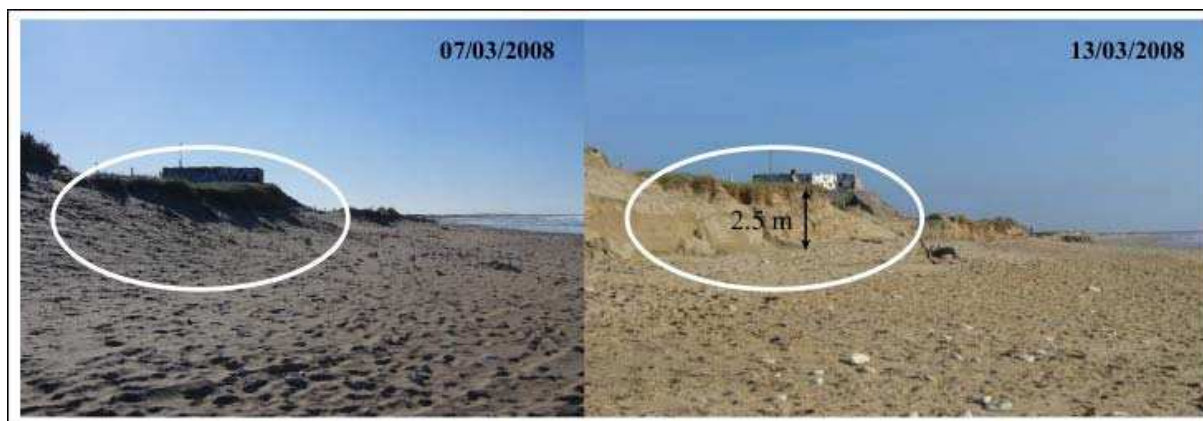
Figure 89 : Impact de la tempête du 10 mars 2008, site de Vert-Bois
