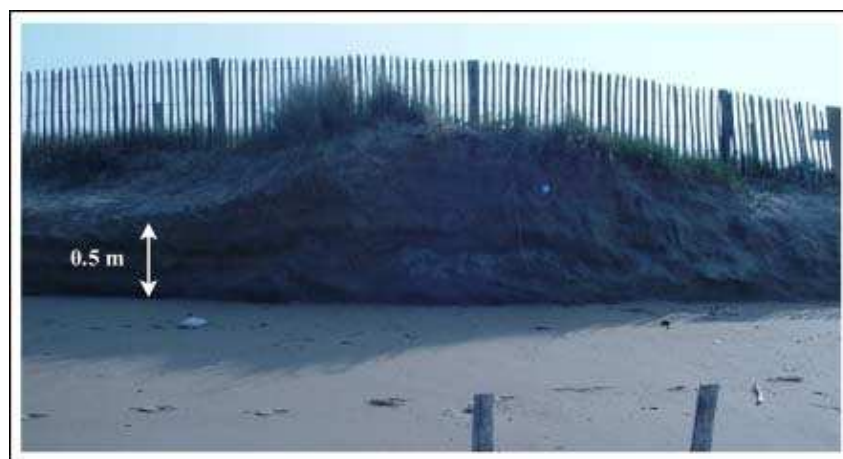
Figure 79 : Les dégâts causés par le coup de vent du 02 février 2003 (Vert-Bois)
