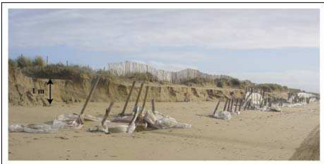
Figure 78 : Les dégâts causés par le coup de vent du 20 janvier 2003 (Vert-Bois)
