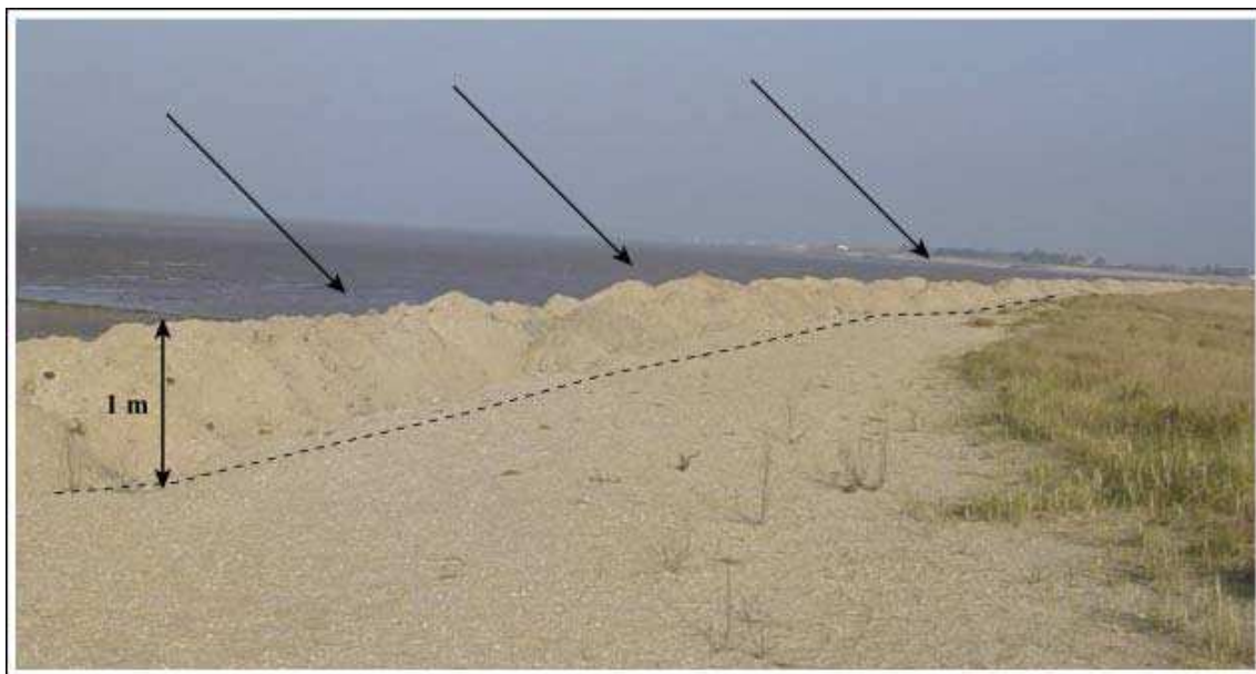
Annexe 25 : Transfert de sable effectué en janvier 2007 à Marennnes-Plage
