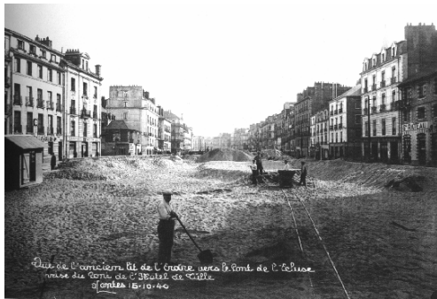
Figure 3.7 : Travaux de comblement de l'Erdre datant du 15 octobre 1940
