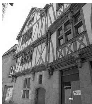
Figure 3.39: Deux types de maisons à pan de Bois dans le centre ancien de la ville : 1) rue Bossuet, RDC en pierre ; 2) rue des Carmes, tout en pan de bois.
