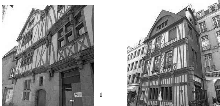
Figure 3.39: Deux types de maisons à pan de Bois dans le centre ancien de la ville : 1) rue Bossuet, RDC en pierre ; 2) rue des Carmes, tout en pan de bois.
