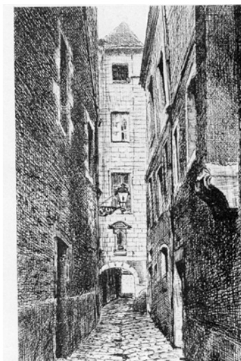
Figure 3.14 : Rue de la vierge du quai de la Fosse, au XVIII ème siècle [COSNEAU 1973]
