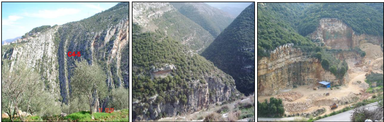
Figure 11. Le C 4-5 dans les vallées de Qadicha, El Asfour et El Jaouz.
