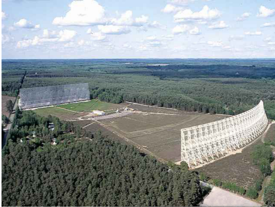
Figure III.5 - Le radiotélescope de Nançay (région Centre) vu du ciel. Le miroir visible en arrière-plan (200 m × 40 m) joue le rôle de premier réflecteur. C'est un miroir plan et orientable, au contraire du second réflecteur au premier plan (300 m × 35 m), fixe et de forme sphérique. Les miroirs sont séparés de 460 m. Ce second réflecteur concentre les ondes incidentes vers le point focal, au centre. Le point visé dans le ciel se déplace au cours du temps à cause de la rotation de la Terre, et par conséquent le point focal se déplace. Pour cette raison, les antennes sont disposées dans un « chariot focal » (on peut le distinguer au centre de l'image) pouvant se déplacer sur des rails. Grâce à ce mouvement, le radiotélescope de Nançay peut couvrir à tout moment \pm \frac{1}{2}^h en ascension droite. Le chariot focal embarque deux récepteurs observant dans les gammes de fréquence 1,1 à 1,8 GHz et 1,7 à 3,5 GHz, permettant de couvrir la raie de l'hydrogène HI et au-delà. L'ensemble forme un télescope méridien, équivalent à une antenne simple de 94 m de diamètre.
