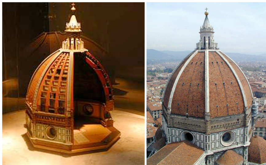
Fig. 1.4. (a) Maquette du Duomo de Florence en Italie. (b) Le dôme tel qu'il a été construit. Les maquettes 3D, pourtant très onéreuses, ont néanmoins été utilisées depuis longtemps pour faciliter la compréhension de projets architecturaux jugés de grande importance : la 3D permet une compréhension intuitive bien plus facile qu'un plan.
