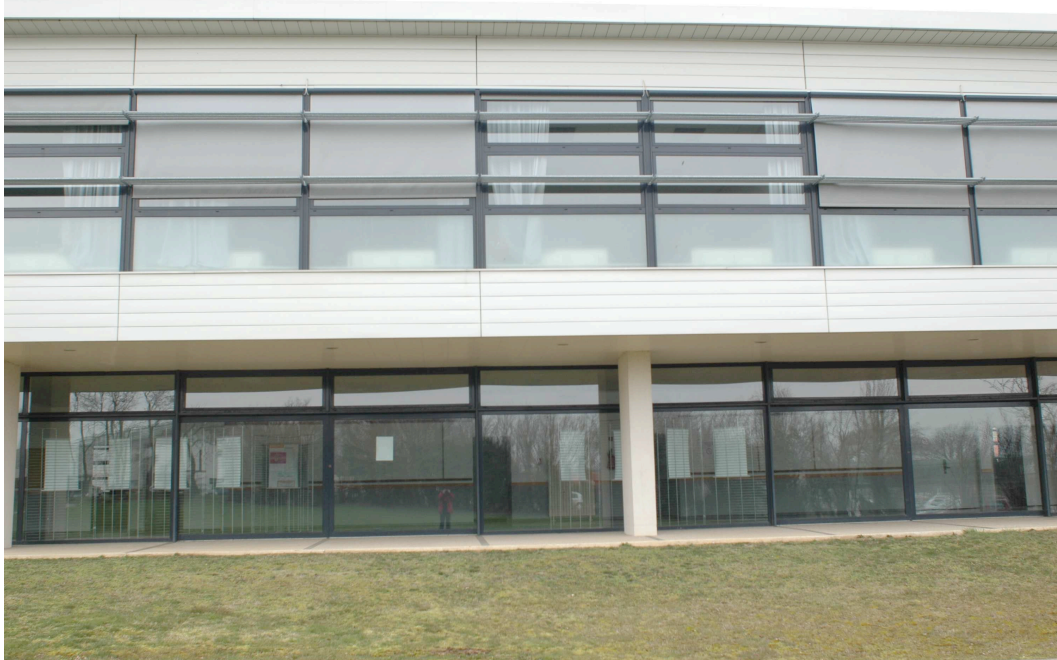
Fig. 2.7. Exemple d'une image avec distorsion, très nettement visible sur le haut du bâtiment (bâtiment de l'ESGT, Le Mans).
