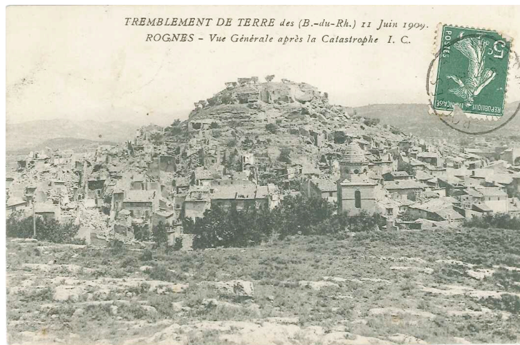
Figure 13: Le village de Rognes (13) détruit par le séisme de Lambesc de 1906. Les dommages plus importants au sommet du relief laissent supposer des effets de site liés à la topographie.
