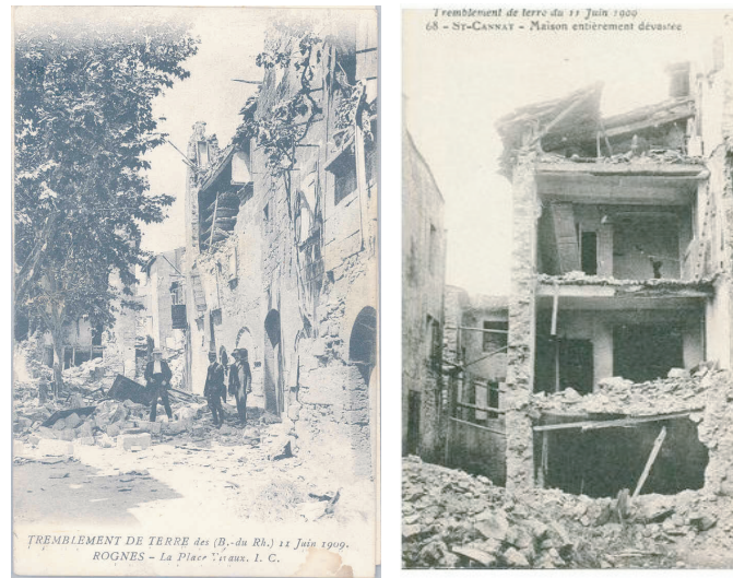
Figure 89: Exemple de dommages observés lors du séisme de Lambesc sur des constructions en maçonnerie
