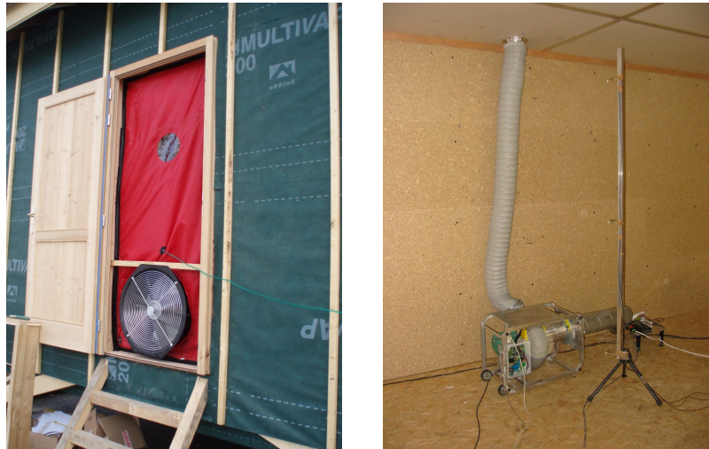
FIG. 2.14 : Mesures de perméabilité à l'air : à gauche mesure à la fausse porte, à droite mesure avec un perméoscope
