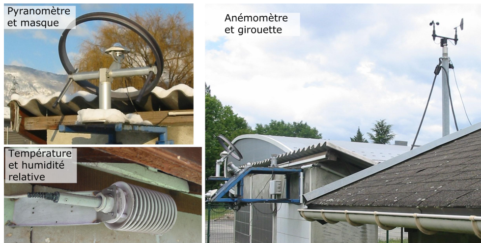
FIG. 2.13 : Détails de la station de mesures météorologiques
