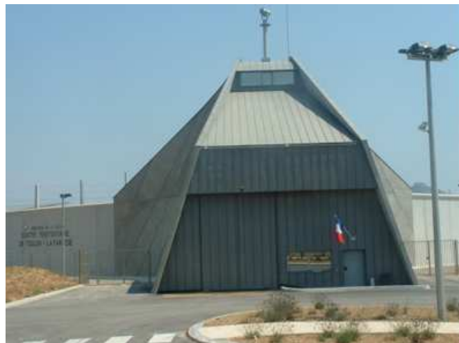
Photographie 8 – Entrée du centre pénitentiaire de Toulon – La Farlède
