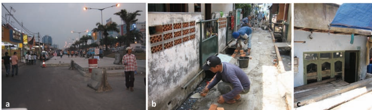
Figure 2.15. La nécessaire surélévation du bâti comme conséquence et indice de la subsidence : (a) : surélévation de la rue principale jalan Gunung Sahari ; b : surélévation d'une ruelle ; c : maison qui n'a pas été surélevée, plancher à 50 cm en dessous du niveau de la ruelle. Clichés P. Texier, Pademangan Barat, septembre 2006).
