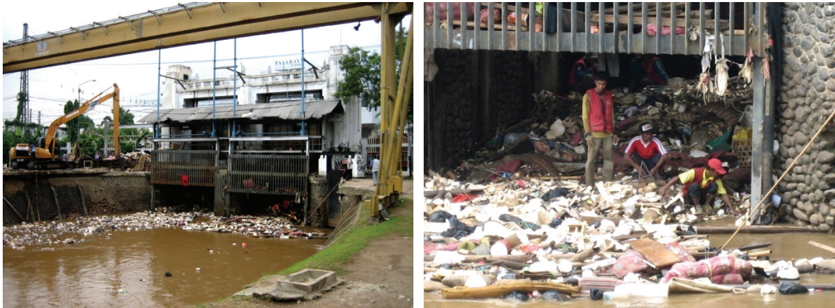
Figure 6.26. Les vannes de Manggarai encore bloquées par les déchets sept jours après le début de la décrue (Clichés P. Texier, 12 février 2007).
