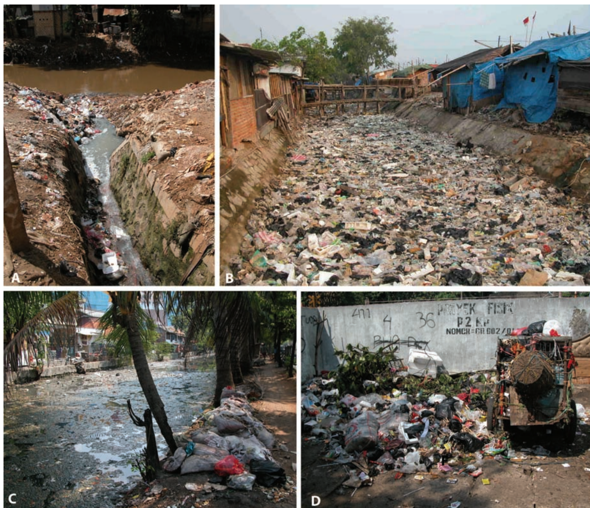
Figure 2.31. Drainage des eaux usées et déchets. A : confluence d'un micro-drain avec la rivière Ciliwung ; B : accumulation de déchets dans un drain à l'embouchure de la rivière Angke ; C : canal de crue pollué à Pademangan ; D : Décharge informelle à Pademangan (clichés P. Texier, 2005-2007).
