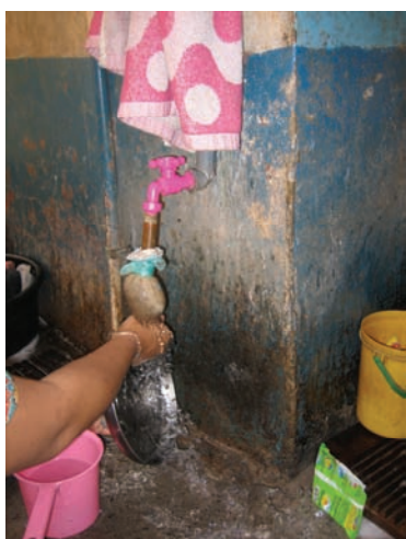
Figure 4.28. Filtration de l'eau PAM à travers un linge et du sable (cliché P. Texier, septembre 2006, Bukit Duri).
