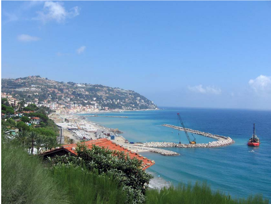
Photo 22 - Port de plaisance en cours de construction à Ospedaletti (IM)
