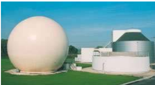
Gazomètre contemporain (stockage de gaz à basse pression)
