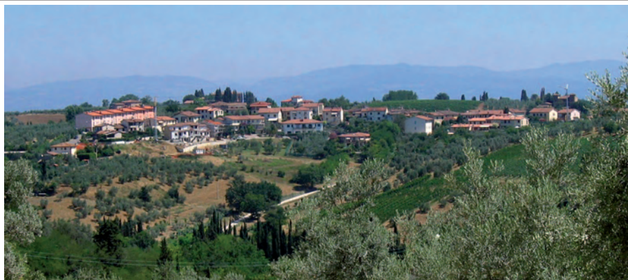
A. La fraction de Spedaletto (San Casciano) s'agrandit de manière compacte (deux grues visibles à gauche et à droite).
