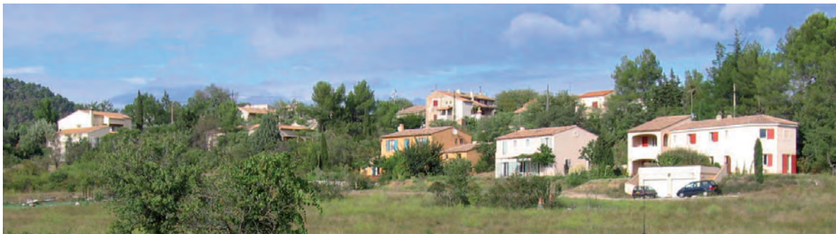
B. Les nouvelles maisons construites aux abords des Artauds au Tholonet depuis l'adoption de la ZPPAUP sont très visibles depuis la RD64C alors que le vieux hameau serré sur la crête est pratiquement masqué par la végétation.
