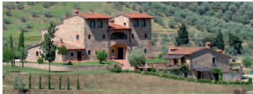
C. Une ferme rénovée entourée d'un jardin.
