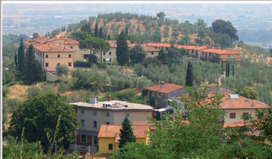
A. Le lotissement de la villa Rasponi: au premier plan, le village de Carmignano. Au second plan la villa Rasponi (à gauche) a été entourée de maisons en ligne, formant un complexe résidentiel fermé ( gated ).
