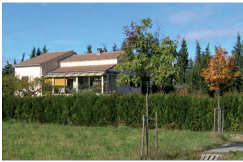
A. Une petite maison neuve de la zone maraîchère d'Eygalières (le long de la RD 74).
