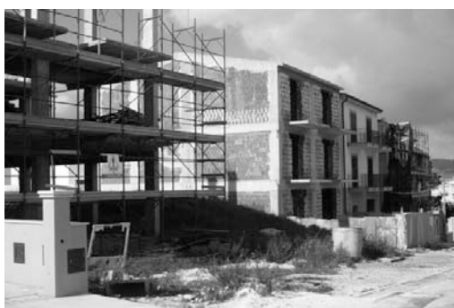
Une maison en construction
