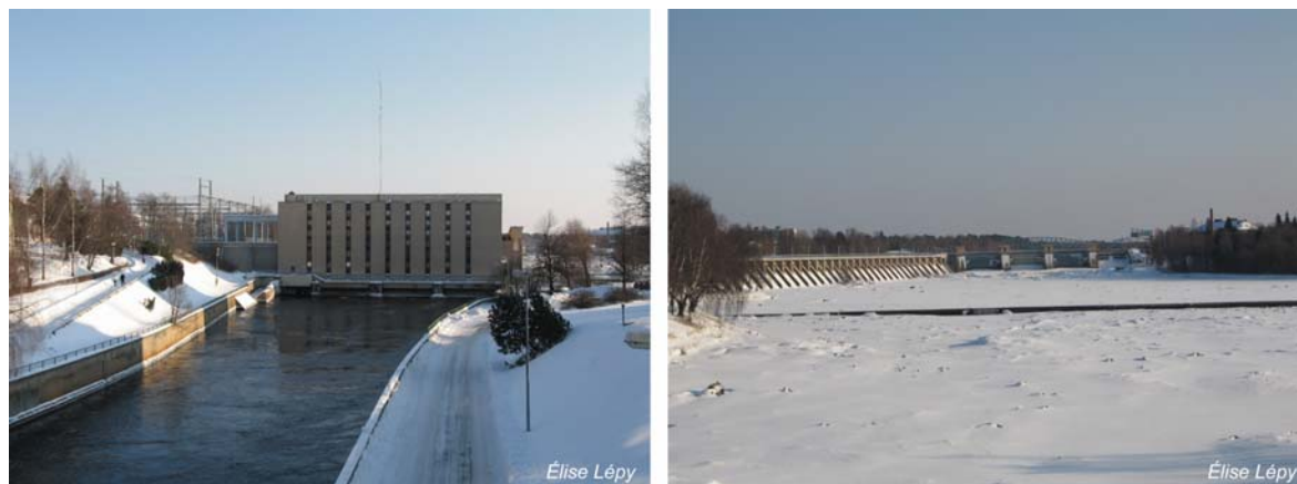
Photographies 12 – La centrale hydroélectrique et le barrage de Merikoski (Oulu) – 22 février 2009 Pictures 12 – Merikoski hydropower plant and dam, Oulu – February 22 nd 2009
