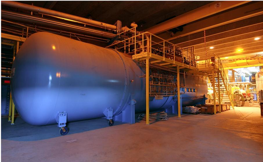
FIGURE 4.21 – boîte froide 18 kW à 4,5 K pour le LHC (Linde)
