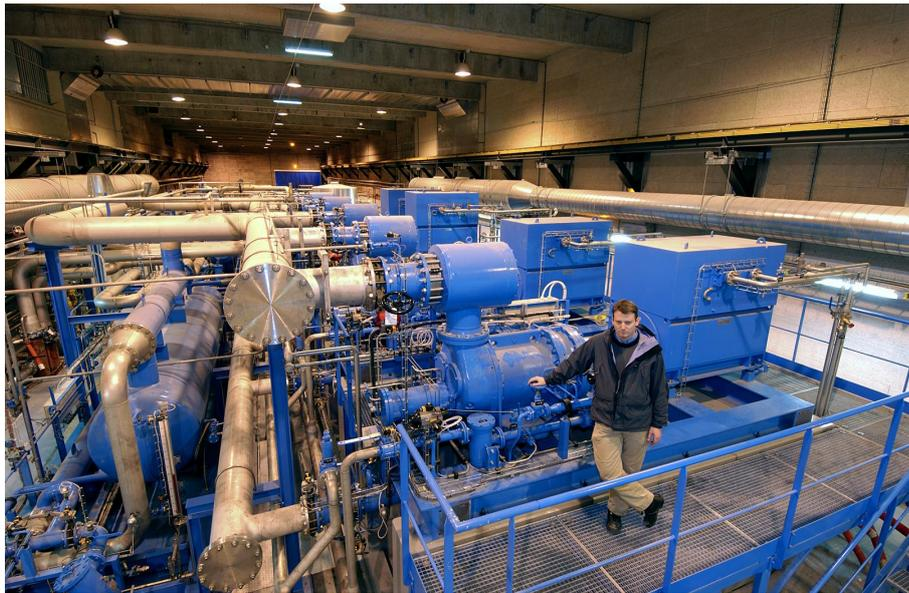
FIGURE 4.17 – Station de compression chaude pour le LHC
