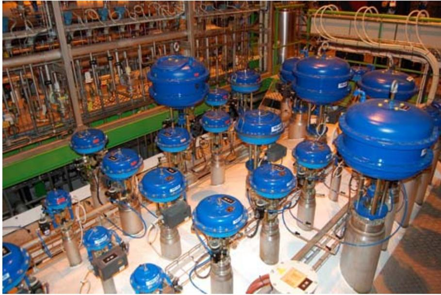
FIGURE 3.10 – Têtes de vanne sur une boîte froide du LHC
