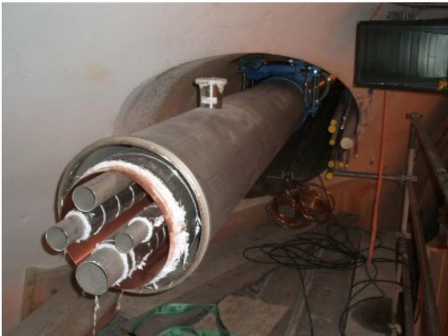
FIGURE 3.6 – Ligne de transfert cryogénique
