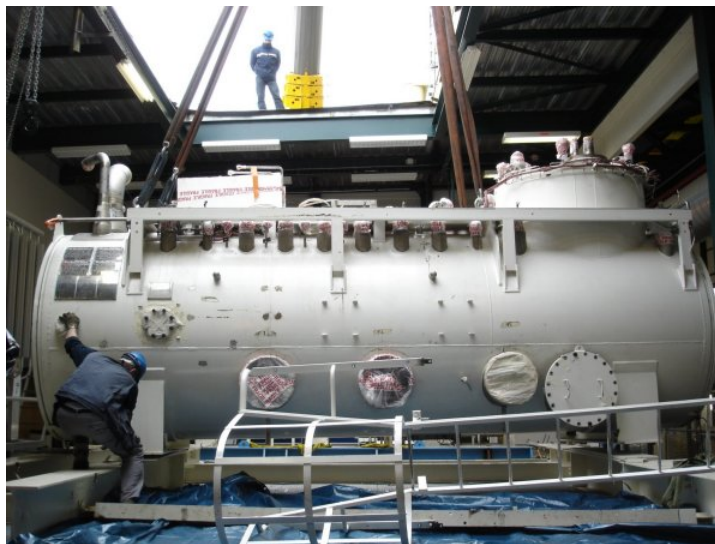
FIGURE 4.2 – La boîte froide pendant son installation
