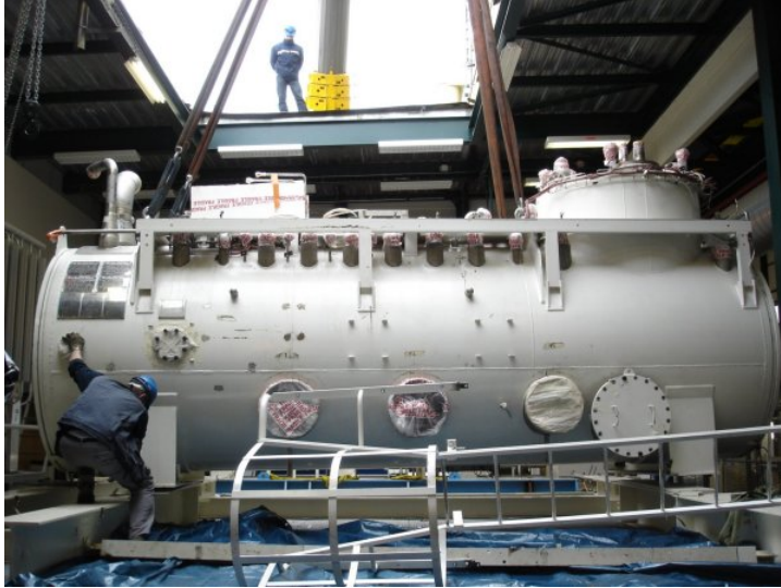
FIGURE 4.1 – La boîte froide pendant son installation
