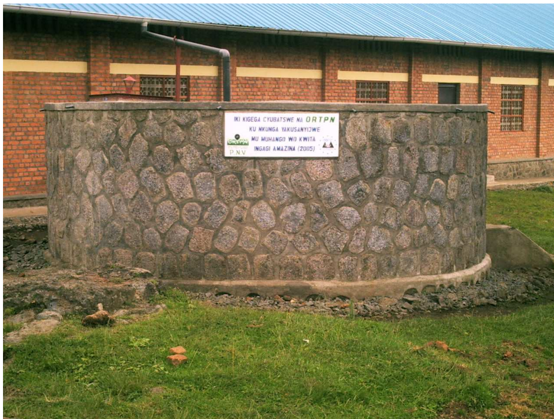
Photo 15 : Une citerne de collecte d'eau de pluie construite par l'ORTPN dans le secteur Kinigi/District de Musanze (Photo G. Rwanyiziri, 2007)
