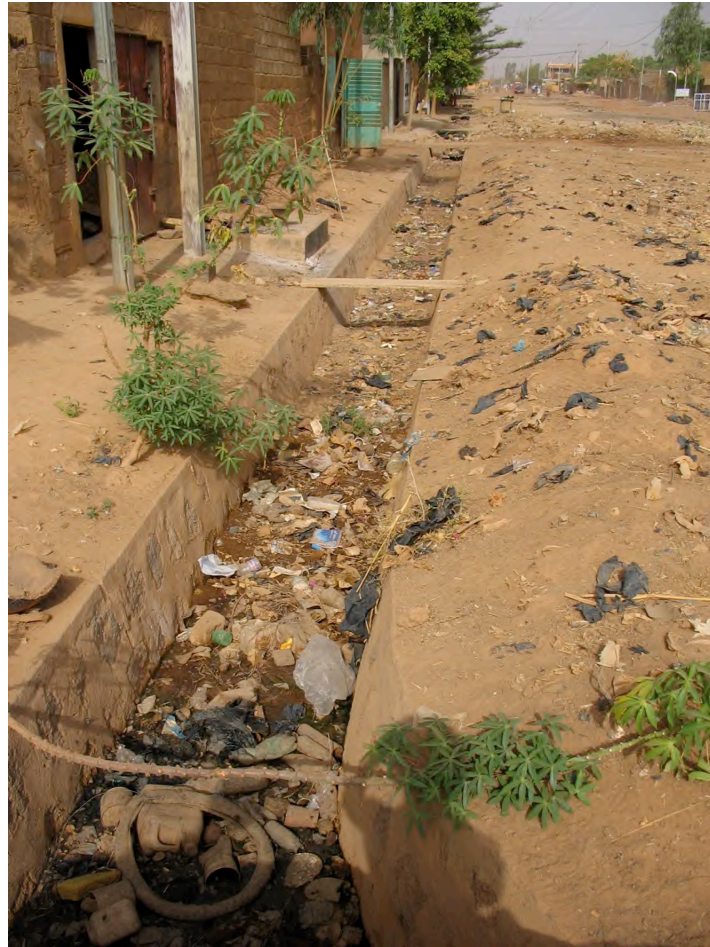
Photo 18 : Égout à ciel ouvert – Ouagadougou
