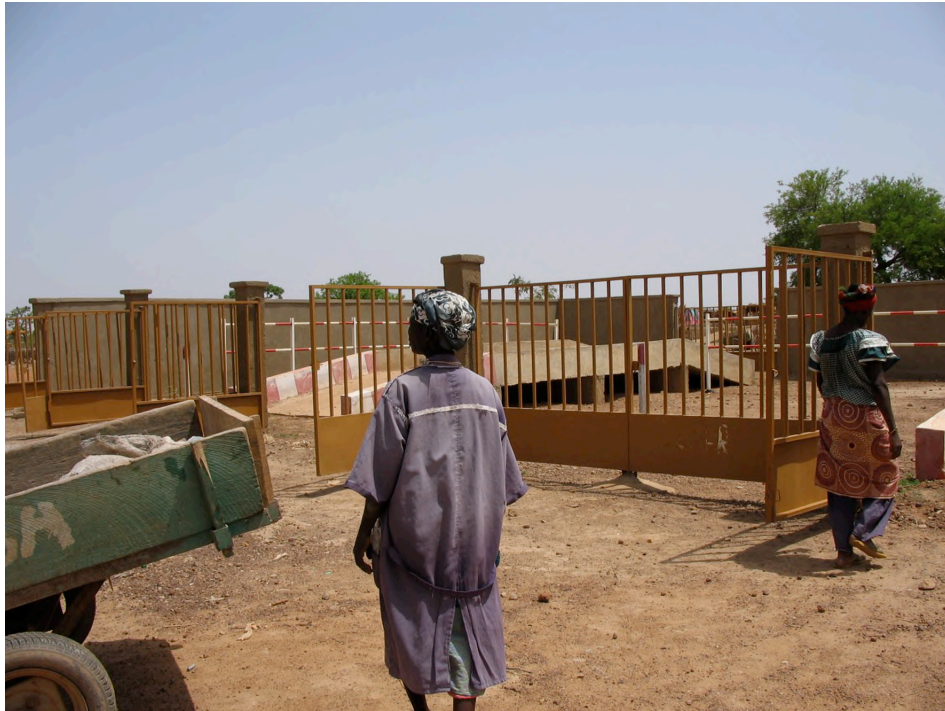
Photo 16 : Centre de collecte intermédiaire avant son ouverture – Sigh-Noghin – Ouagadougou Au premier plan, des précollecteuses et leur charrette en bois. Au fond, la rampe d'accès pour les camions faisant la navette avec le CTVD
