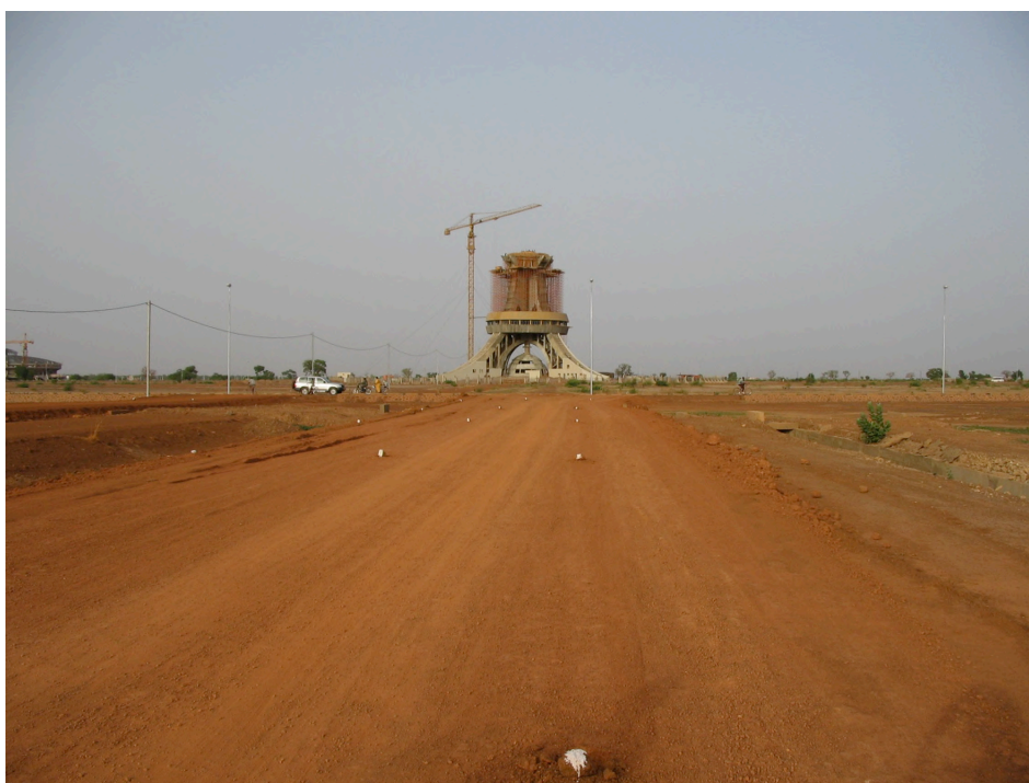
Photo 19 : Le monument aux héros nationaux en construction et la future voie à goudronner – Ouaga 2000 – Juin 2005.
