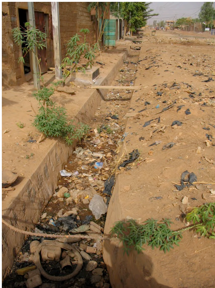
Photo 18 : Égout à ciel ouvert – Ouagadougou
