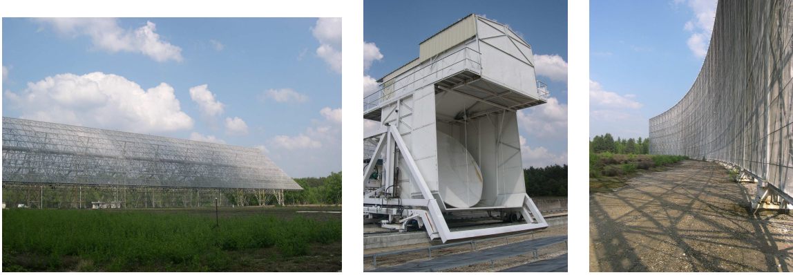
FIG. 2.3: Gauche : miroir plan. Milieu : chariot focal. On peut voir à l'intérieur le miroir secondaire incliné tandis que le miroir tertiaire (caché) est monté au niveau du triangle de la partie supérieure. Droite : miroir sphérique (credit : Y. Libert)
